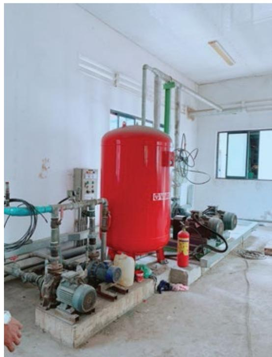
*Bình áp VAREM 1000L, 10bar /VAREM pressure tank 1000L, 10bar*
