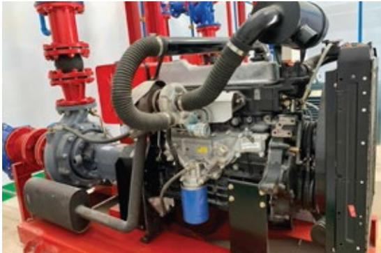
Máy bơm rời trực với Động cơ Diesel /Diesel Engine Drive Pump
