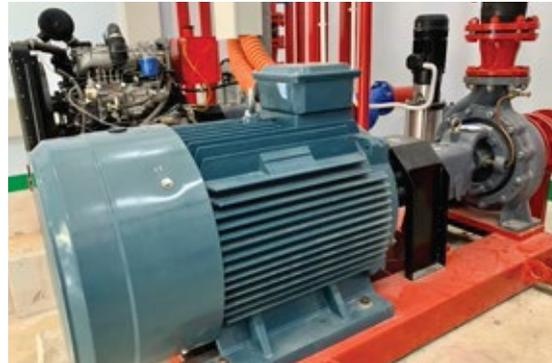
Máy bơm điện rời trực với motor /Electrical Drive Pump
