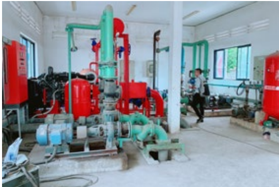
Phòng bơm PCCC của nhà máy Hyundai Welding Vina được nâng cấp công suất. /Fire fighting pump room of Hyundai Welding Vina factory upgraded capacity.
