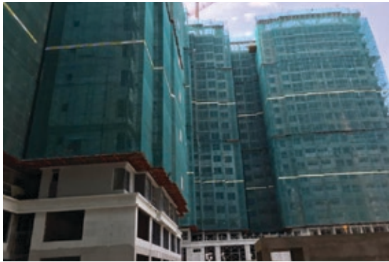
Khảo sát tại công trình /Surveying at the construction site
