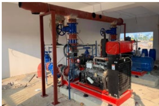
Máy bơm với động cơ Diesel công suất lớn ISUZU VERSAR - SINGAPORE /High capacity pump with Diesel engine ISUZU VERSAR
