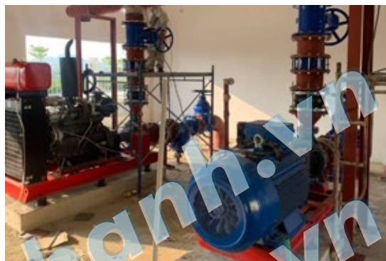
Máy bơm motor điện công suất lớn ELEKTRIM - SINGAPORE /High capacity pump with Electric motor Elektrim
