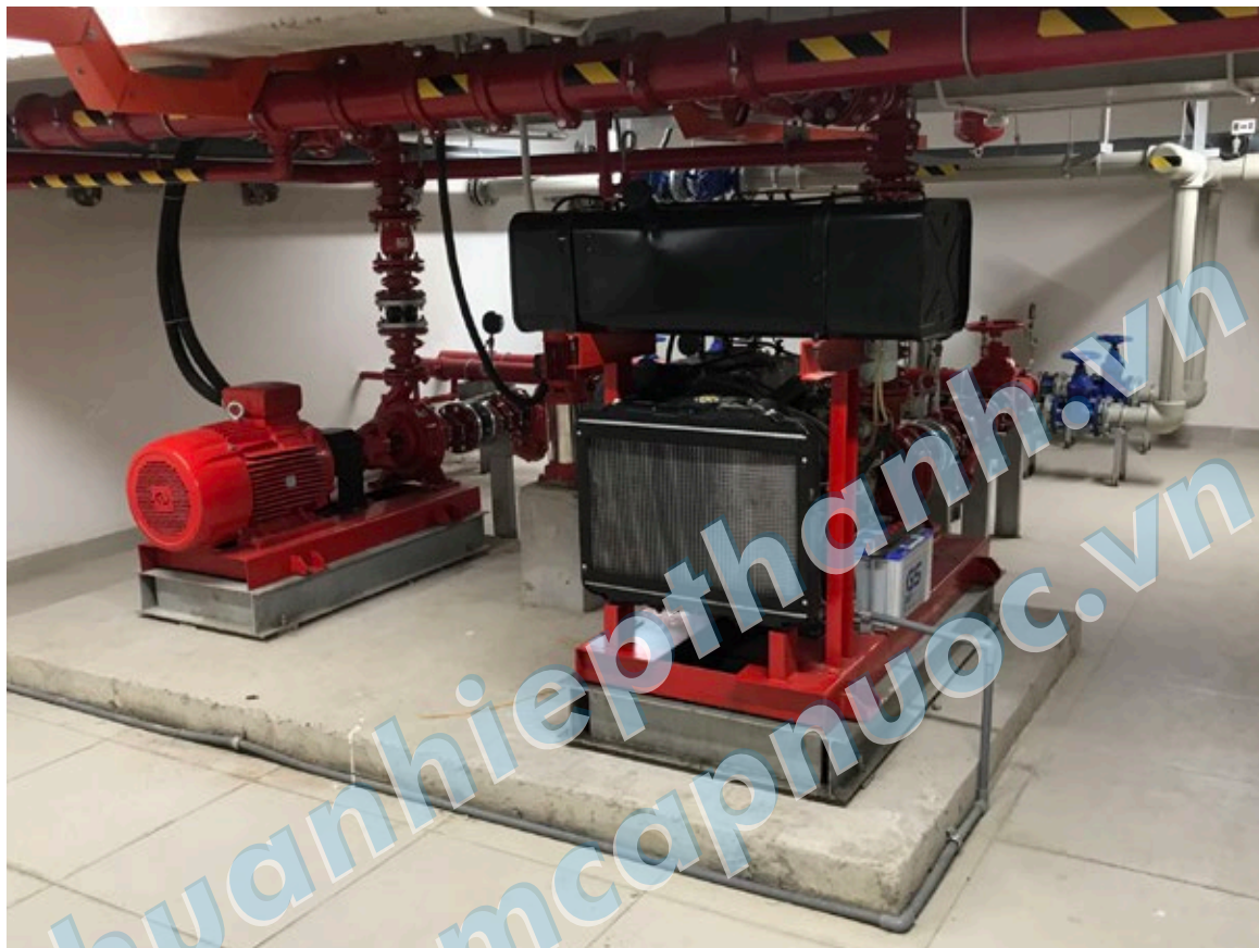
Bơm điện (trái) và bơm Diesel (phải) trong phòng bơm của trường EMASI Nam Long /Electrical drive pump (left) and diesel engine drive pump (right) inside EMASI Nam Long pump room
