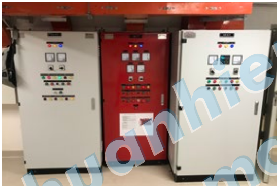
Tủ điều khiển /Controllers
