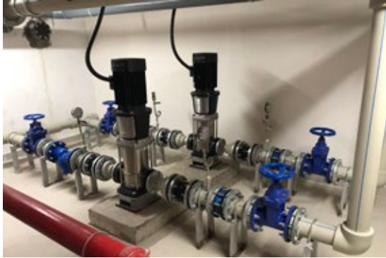
Hệ thống bơm bù áp /Booster pumps
