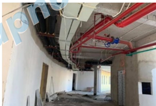
Đường ống chữa cháy trong tòa nhà /Pipes of Fire fighting system
