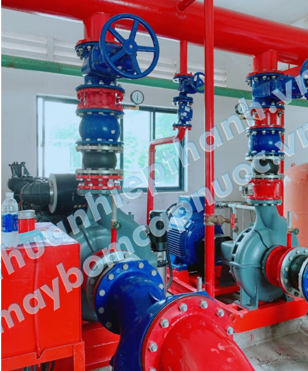
Máy bơm công suất lớn với động cơ Diesel HYUNDAI - KOREA 240HP/179KW đầu bơm EBARA - INDONESIA
