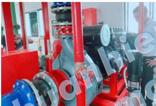
Kiểm tra máy bơm trước khi nghiệm thu /Check the pump before acceptance
